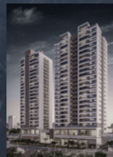
HIGH JD. PRUDÊNCIA RUA DAS FLECHAS, 484
