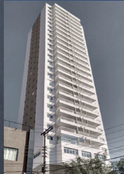
BRISE VERGUEIRO RUA GUANABARA, 110
